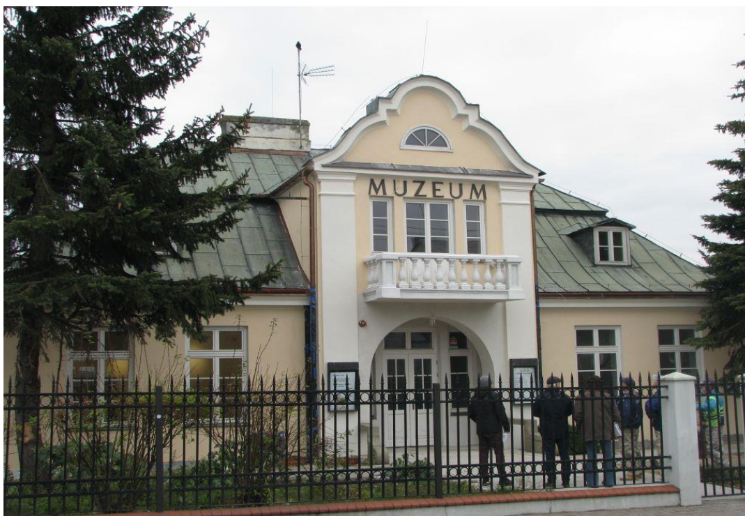
Fot. nr 9 Budynek Muzeum Ziemi Rawskiej po remoncie
